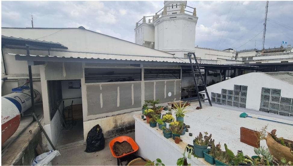
Con el apoyo del taller de herrería y tablayeso se realizó el remozamiento del área de jardinería, la cual es utilizada para el resguardo de plantas y materiales que son empleados para la hornamentación de las áreas verdes de la Secretaría, en la que se instaló estructura metálica y muros de durock.
