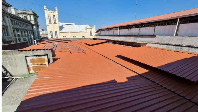
Como parte del apoyo a la dignificación del personal de la SAAS, se procedió al cambio de láminas en el área de Mantenimiento de Edificios, ya que las anteriores se encontraban deterioradas generando filtraciones en época de lluvia, también se instalaron estructuras tipo sifón para mejorar la ventilación del ambiente de los talleres.
